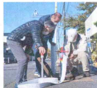
スタンドパイプの設置
