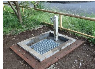
改修された手洗い場 つばき公園
