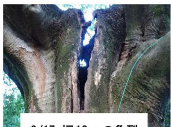
8/17 幅12cmの亀裂
