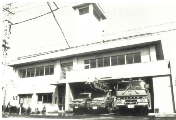
東久留米消防署前沢出張所 （東久留米消防署提供）
